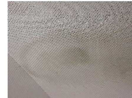
...ist dieser Schmutz ziemlich hartnäckig. Hier muss noch weitergeblasen werden, bis sich...
